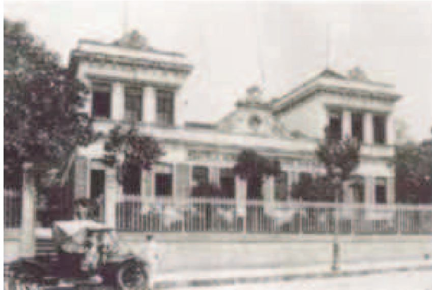
Figura 1 - Escola Gonçalves Dias com sua conformação original. Reparar a conformação simétrica em alas e a presença do relógio acima da ala central (DRAGO & PARAIZO, 1999).
