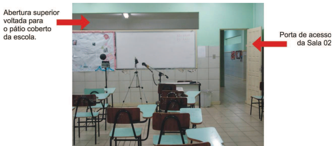
Figura 48 - Vista interna da sala com abertura superior para favorecer a ventilação cruzada.
